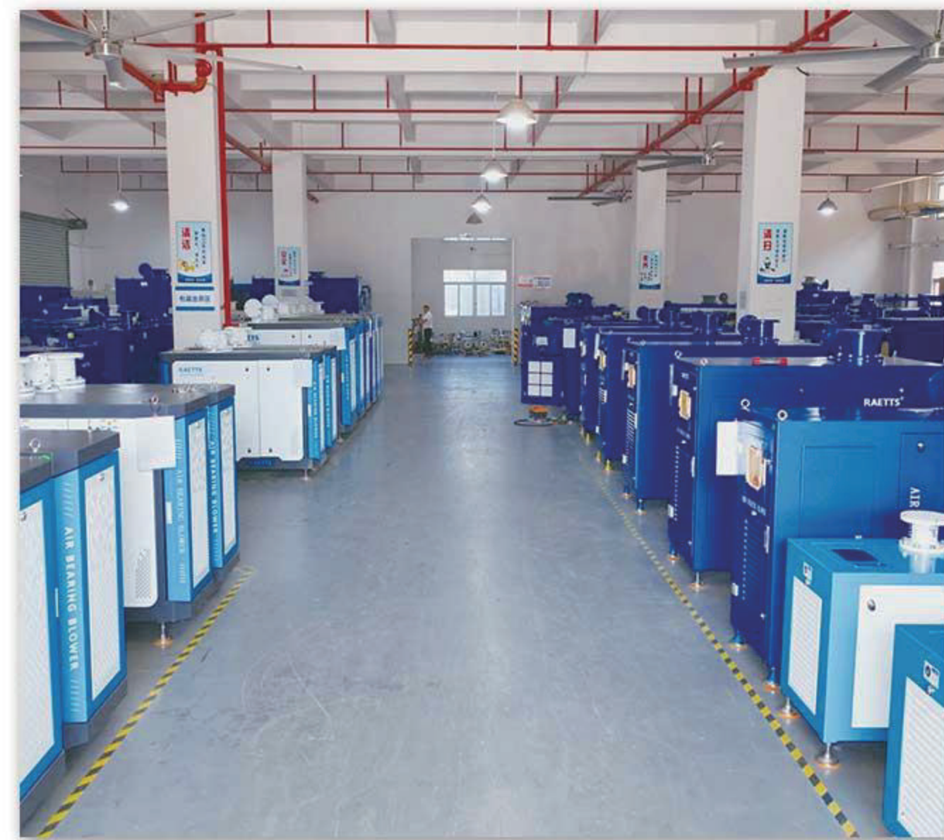
风机组装中心
