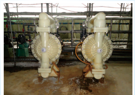
污水處理安裝實績
